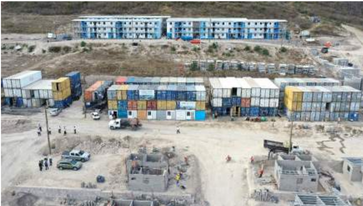
Fuente: inspección in situ realizada por la UIASC del CNA.
